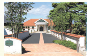
現在地に新本社を建設。
